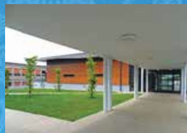
Entrée du lycée Raphaël Elizé
