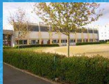
Gymnase du lycée
